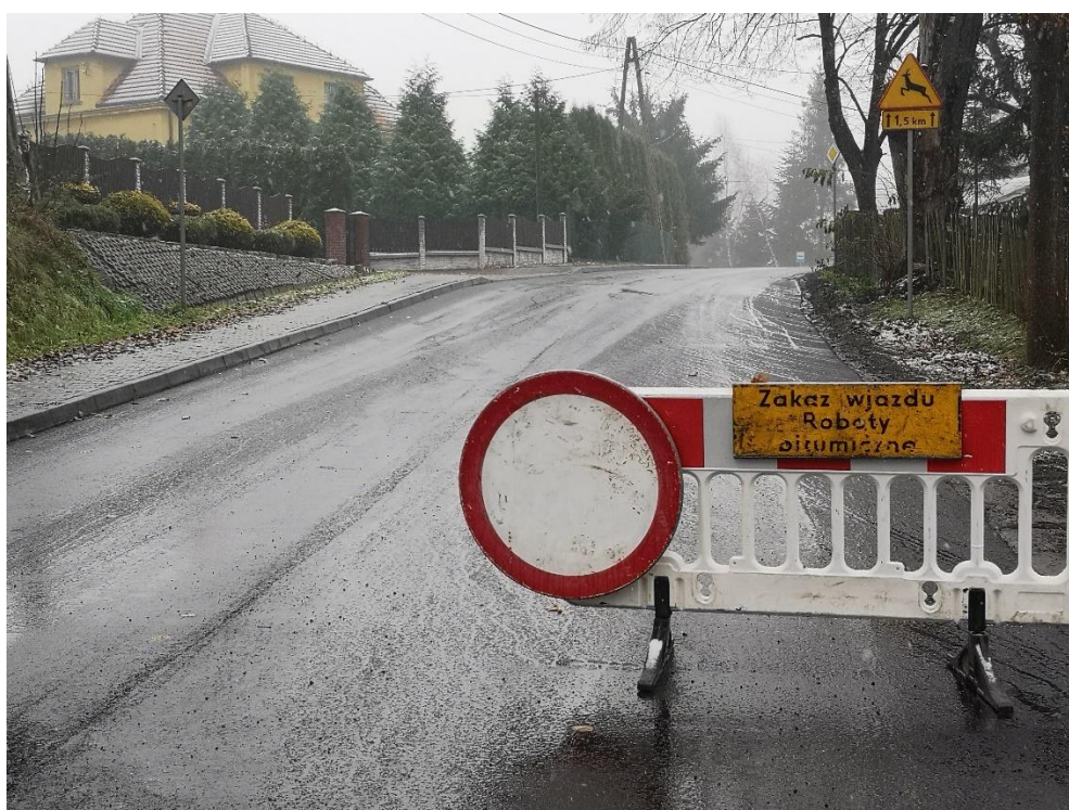
Ilustracja 8 Remont drogi powiatowej ul. Wspólna w Zygodowicach
