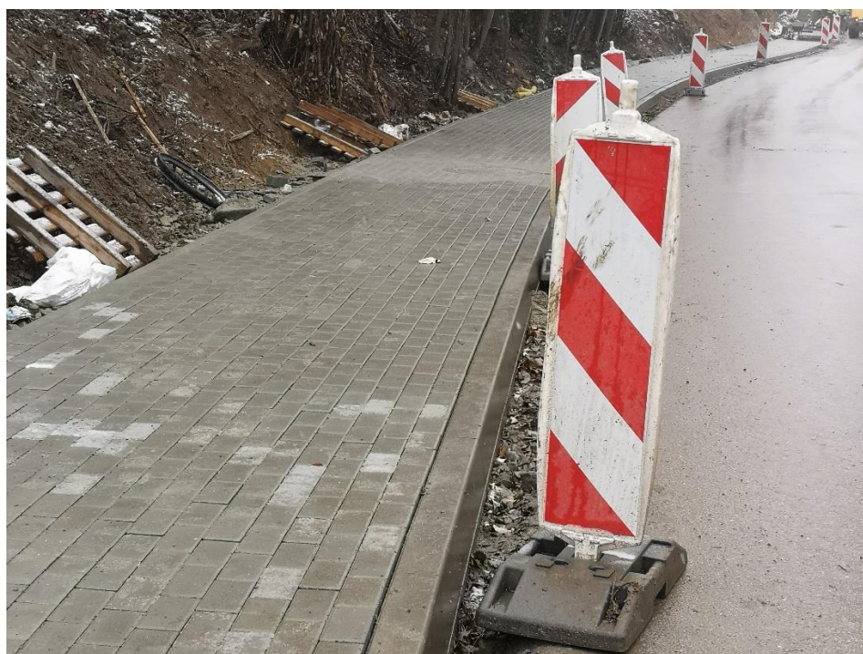
Ilustracja 6 Budowa chodnika przy drodze powiatowej ul. Wspólna w Tomicach
