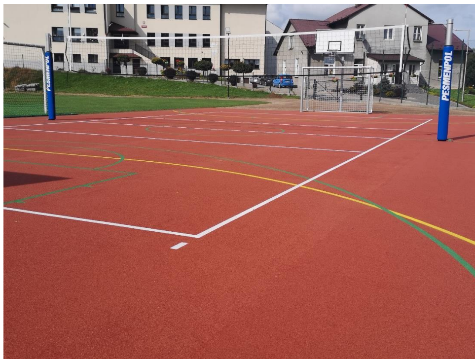
Ilustracja 4 Wyremontowane boisko wielofunkcyjne w Radoczy
